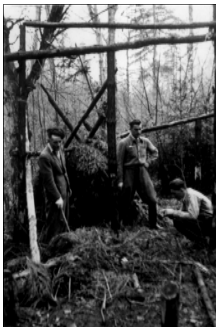
Odbudowa szalasów na Wykusie, — październik 1943 r.
